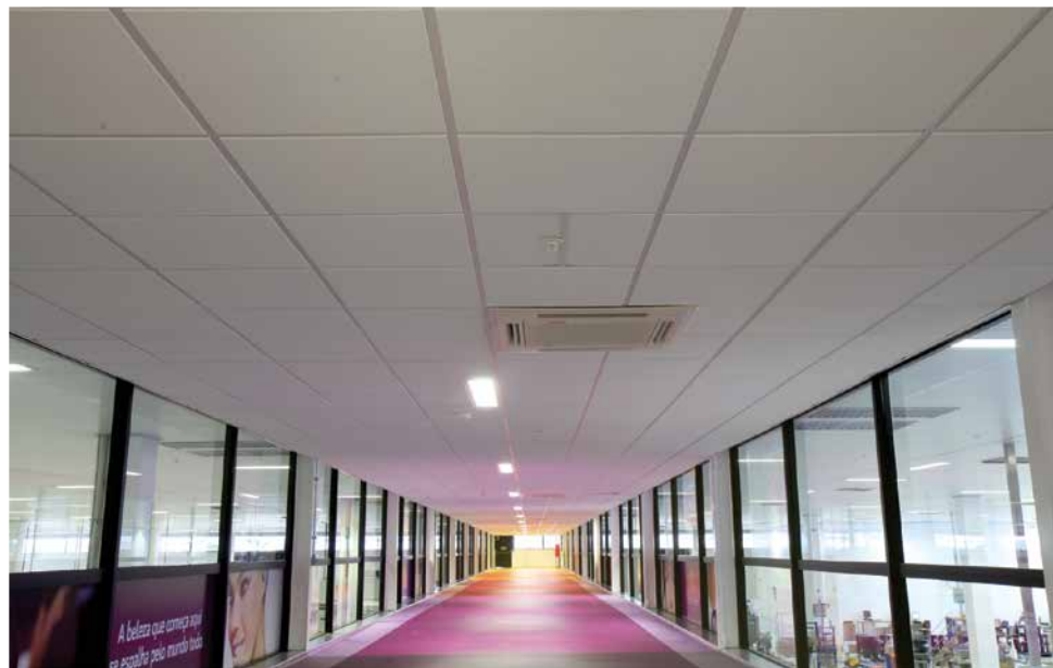
FÁBRICA DE MAQUIAGEM O BOTICÁRIO | SÃO JOSÉ DOS PINHAIS PR
