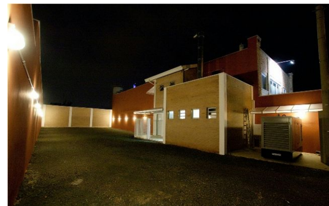
Estacionamento e Gerador Próprio
