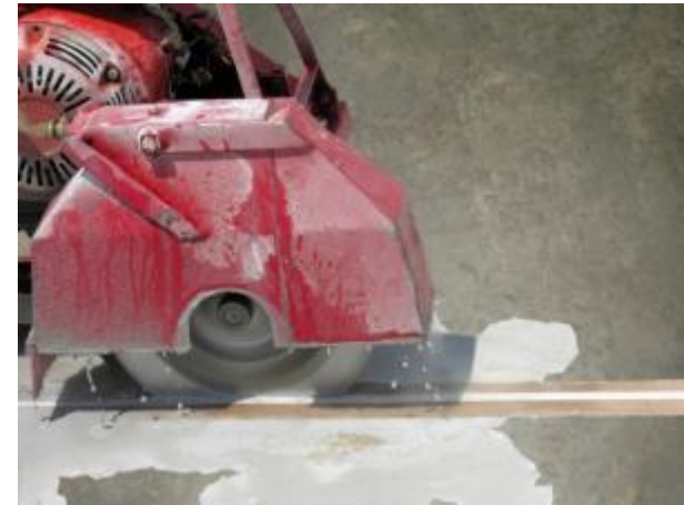
Recuperação da junta do concreto
