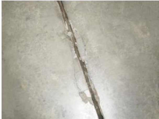
Junta do concreto comprometida
