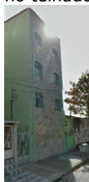
- CONDOMINIO ED AGUARIUS - Rua Bragança, 220 - Eldorado - Contagem - Serviços de pintura com aditivo impermeabilizante sobre a fachada, bem com pintura da garagem, esquadrias e muros
