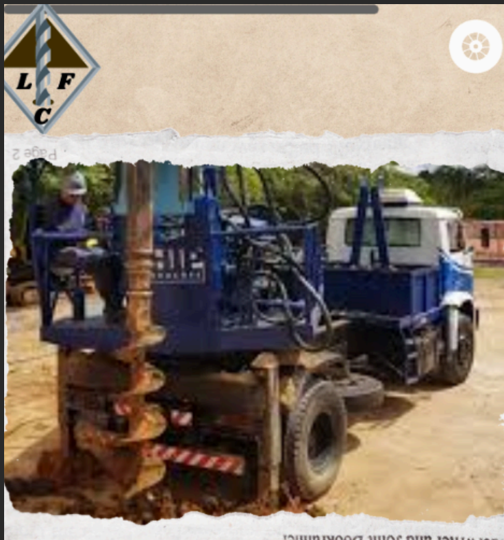
Fundação Tipo Escavada
